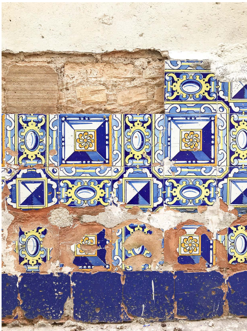
Figura 13. Pasaje H. Upmann y Valle. Vivienda ubicada en la intersección de estas calles, con la pared lateral cubierta enteramente con la baldosa, hasta la altura de las ventanas.
