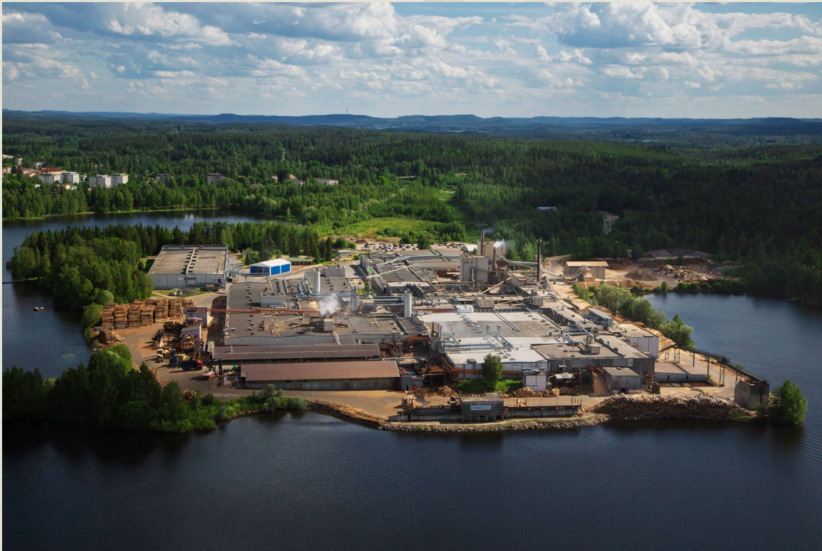
Megaplanta de productos ingenieriles de madera para la construcción sostenible de Metsä Wood, en Suolahti, Finlandia. Fotografía: Metsä Wood.
