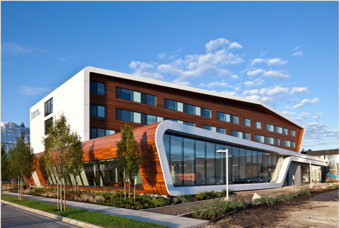
Uso exterior de la madera en edificios. Centro de Medios Digitales, Vancouver, Canadá. Fotografía: Derek Lepper, cortesía de naturallywood.com.
