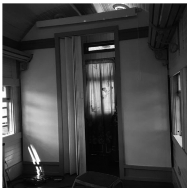
Figura 10 Finalización de la construcción de la divisoria, la puerta plegable y la pantalla para proyecciones (2019)
