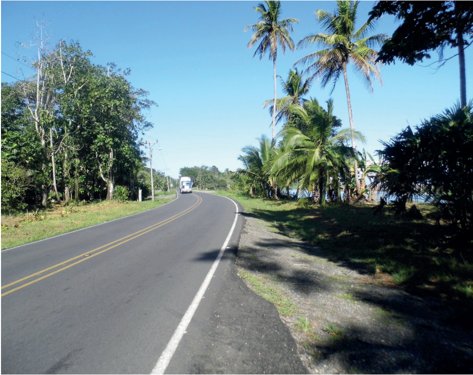
Figura 9. Proximidad de la carretera con la zona de erosión de playa.
