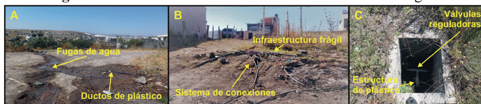
Figura 5. Infraestructura utilizada en la distribución del agua.
