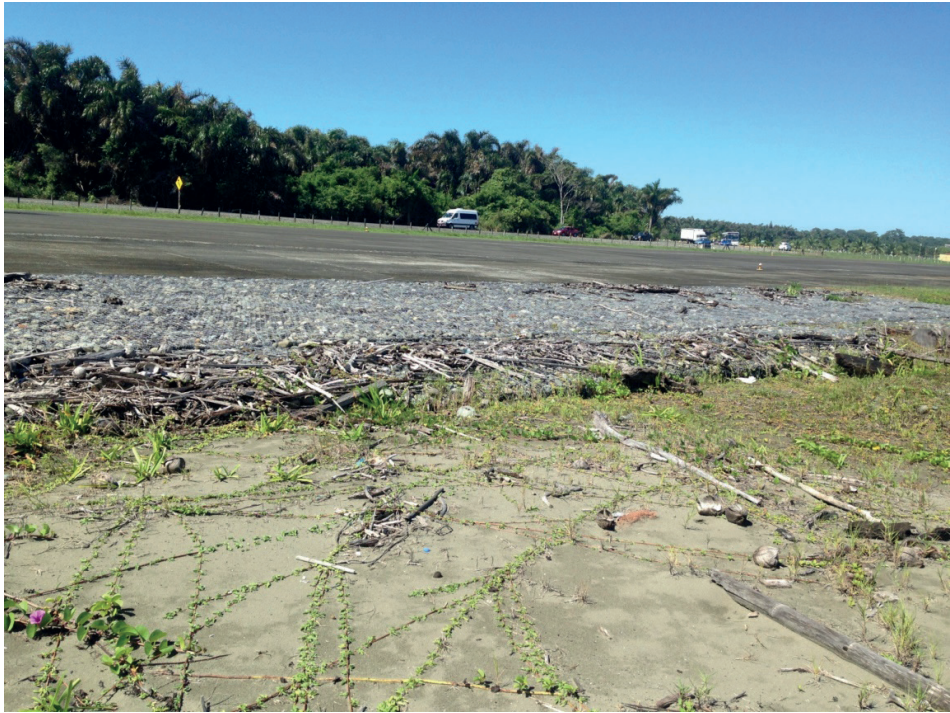
Figura 6. Revestimiento pedregoso con malla a un costado de la pista de aterrizaje donde la erosión ha obligado a proteger la obra.
