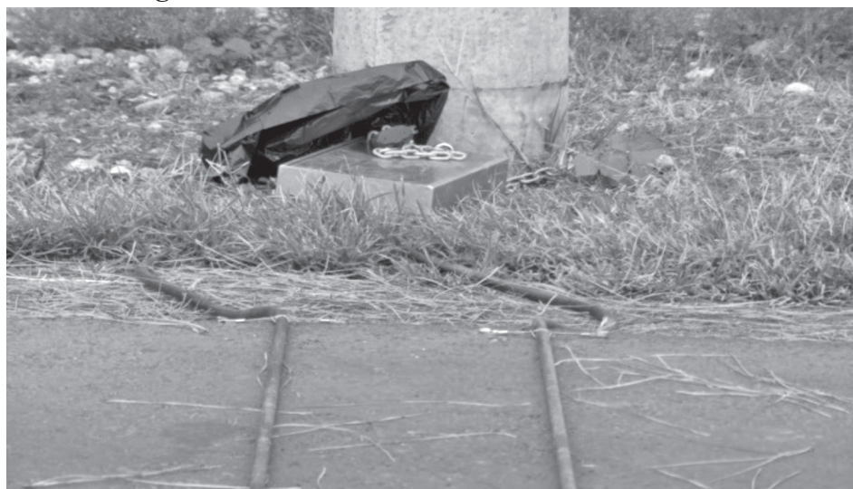
Figura 3. Contador automático de tubos neumáticos
