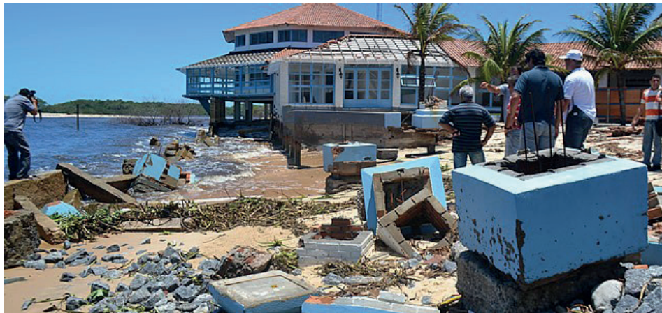
Figura 2. Destruição parcial do La Isla Ecoresort em 2013.
