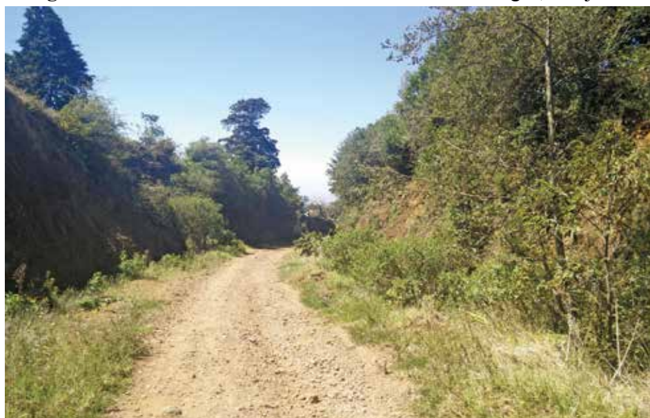
Figura 3. Cauce fluvial intermitente en Calle Montenegro, Fraijanes
