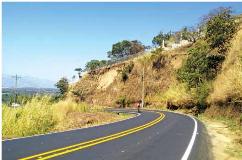
Figura 5. Terrenos inestables y de marcada pendiente en la comunidad Pilas, distrito San Isidro
