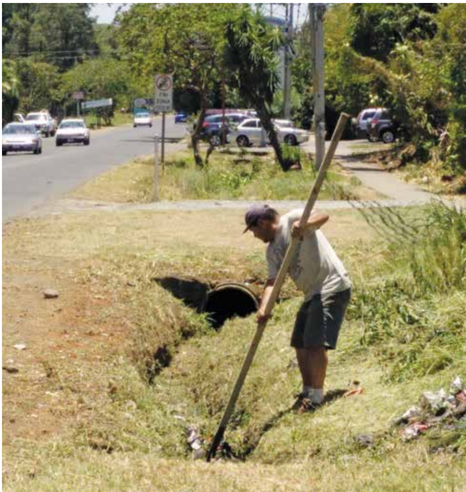
Figura 6. Limpieza de canal frente a la calle principal, El Coyol, distrito San José
