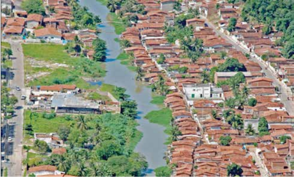
Figura 8. Moradias em situação de risco no bairro São José, João Pessoa (PB)
