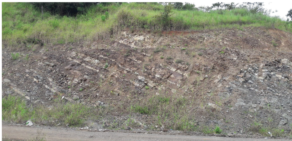
Figura 5. Corte de talud en la entrada a Pesé, con buzamiento de capas por el orden de 45°.
