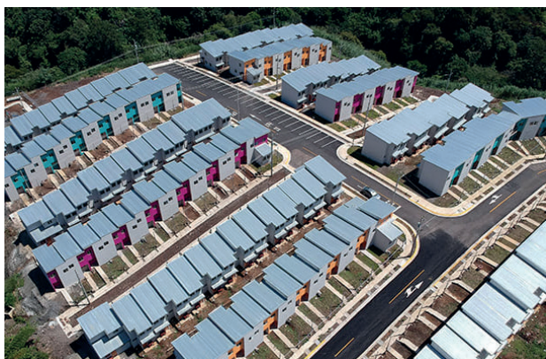
Figura 2. Vista aérea del Conjunto Residencial Shikaba
