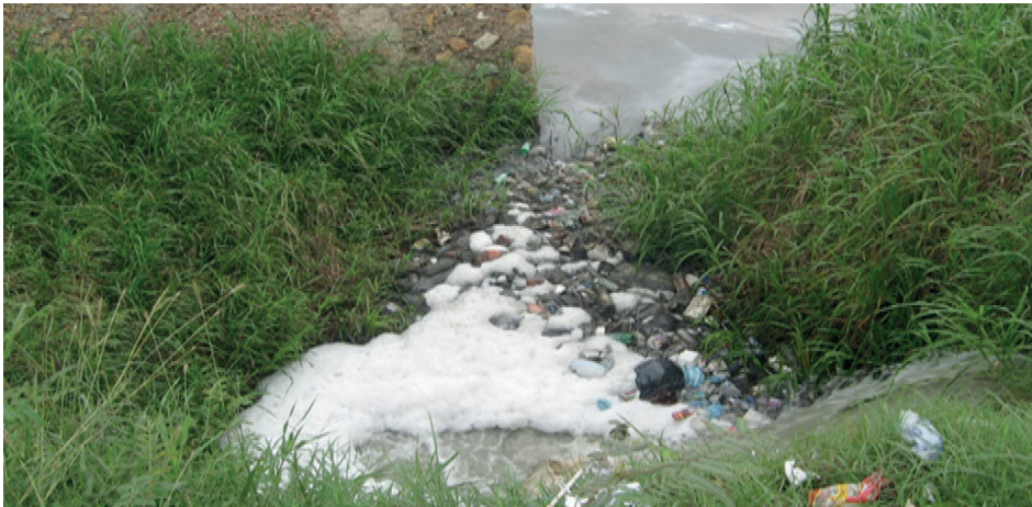
Figura 4. Estado de fuente de agua en el municipio de MOMPOX- Departamento de Bolívar- Colombia.
