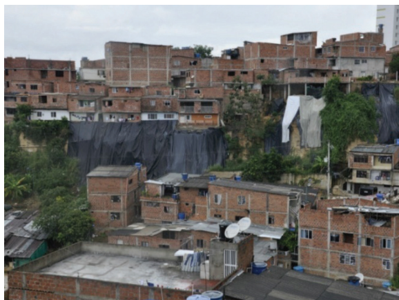
Figura 5: Barrio degradado- Bucaramanga Fuente: Liberal (2013).
