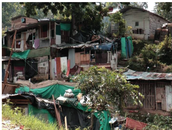
Figura 6: Asentamiento degradado-Bucaramanga Fuente: Liberal (2013).
