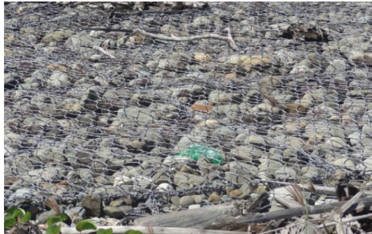
Figura 2. Sector Aeropuerto: Instalación de gaviones. Tomada en campo 6 diciembre 2017.
