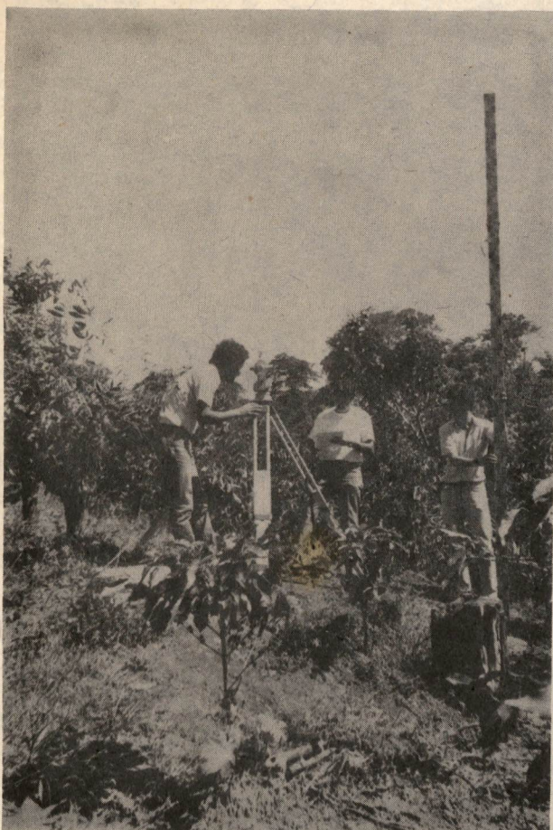
Al Ing. Gerardo Chávez le correspondió dirigir los trabajos topográficos del proyecto de vivienda que se desarrolla en la comunidad de Santa Cecilia de San Francisco de Heredia, el cual albergará cerca de 100 familias.
