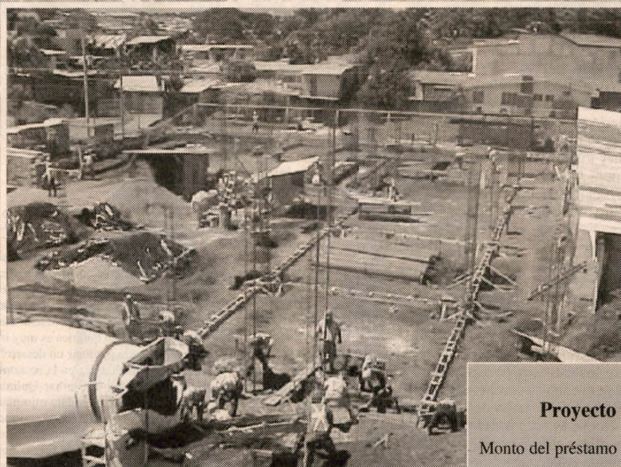
Con el inicio de la construcción del edificio del OVSICORI, arranca la transformación de la infraestructura de la UNA.
