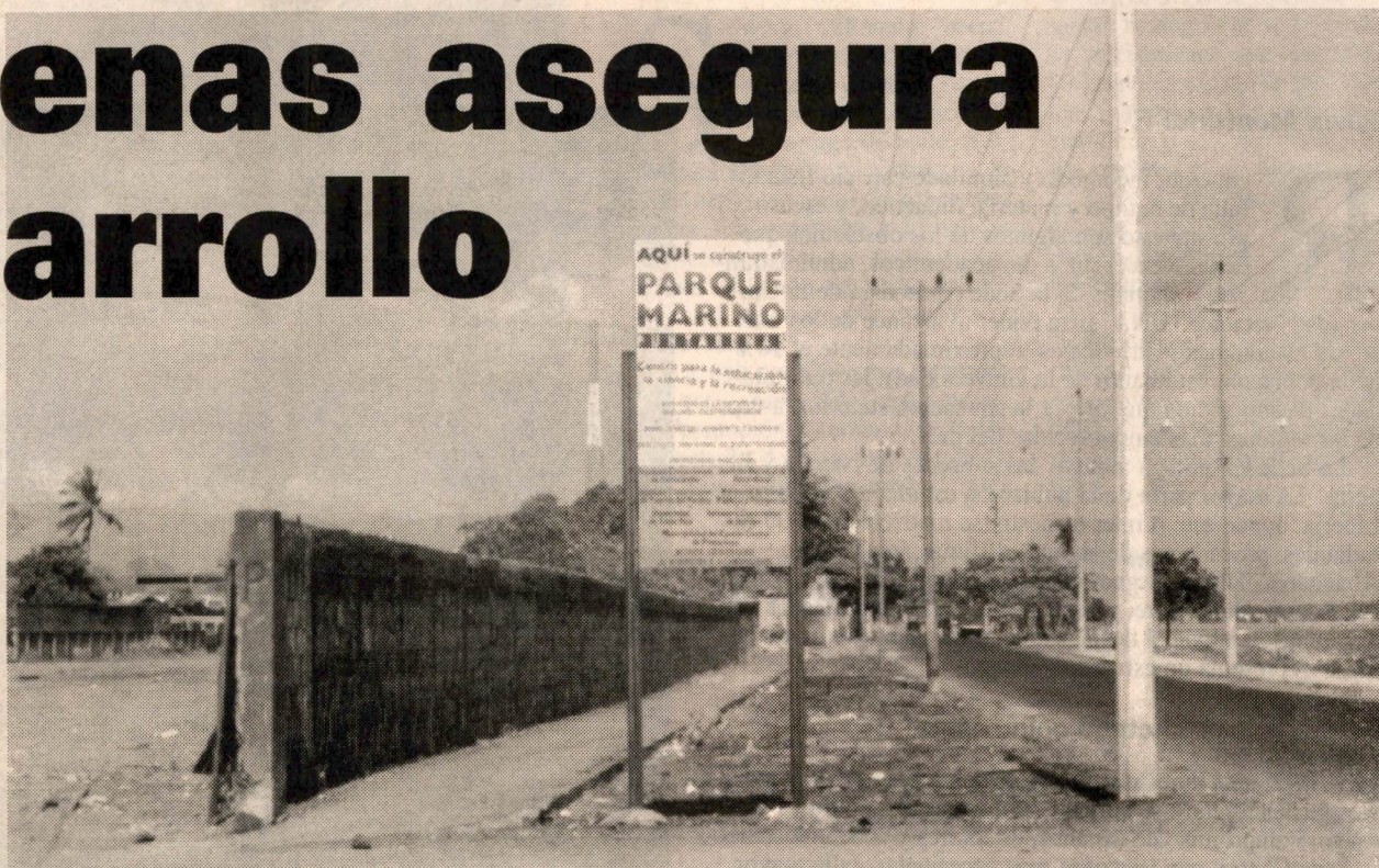
La construcción del proyecto Parque Marino, en el que participan el MINAE, el INA, el INBIO y la UNA, será el motor del desarrollo de Puntarenas y zona aledañas.
