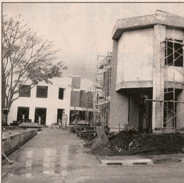
Al ritmo actual de avance de la obra, se espera que el edificio del Centro Internacional de Política Económica de la UNA esté concluido a mediados de octubre próximo.
