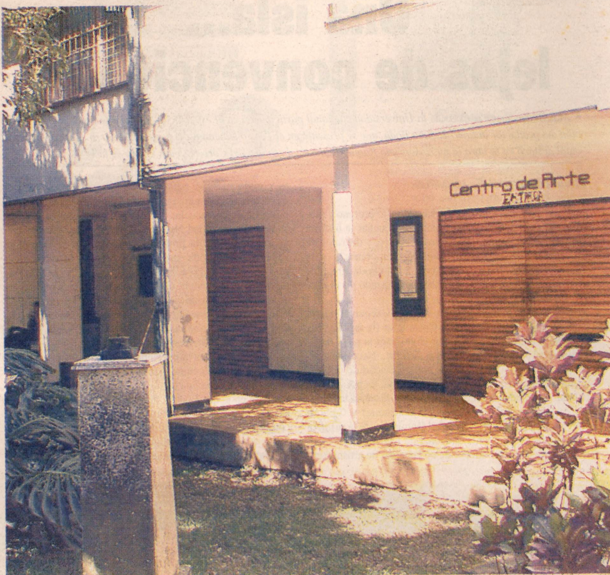
Los pasillos contiguos al Centro de Arte, que hoy se utilizan fundamentalmente como sitio de paso, son parte de los elementos que el proyecto Conjunto Arquitectónico para el Desarrollo de la Docencia y Producción Artística propone integrar para contribuir a la creación de un centro cultural que "le hable al visitante con lenguaje de libertad", como dice el decano del CIDEA, Verny Peña.
