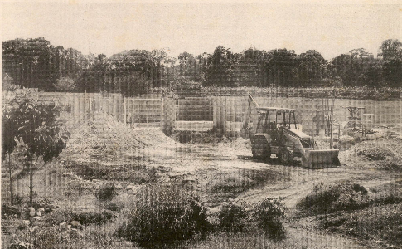
Las obras en la Sede Brunca-Corredores, con un área de 2500 metros cuadrados y un costo aproximado de $1 millón, serán entregadas en junio.
