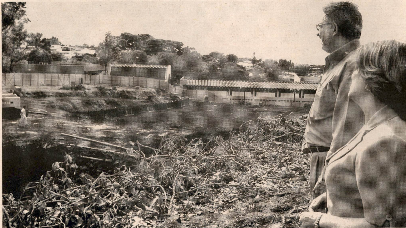
Jorge Alfaro y Lucía Chacón, decano y vicedecana de la Facultad de Filosofía y Letras, son testigos el inicio de las obras que albergarán el nuevo edificio de esta facultad.
